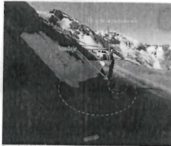
Fotografía N° 007: Plataforma de perforación S/N, el área se encontraba sin perfil y sin revestir. Asimismo, en dicha área se observó un (01) sondaje identificado con código SDO 0026-15.
