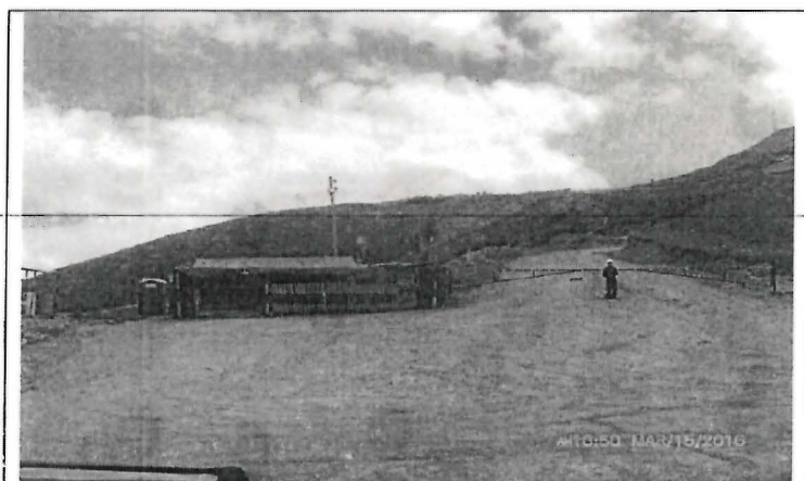
Fotografía N° 27: Vista de la garita de control de ingreso (tranquera) ubicada en la parte alta del cerro El Toro con coordenadas UTM WGS 84 N:9133578; E: 828281 Zona 17M, dentro de la concesión minera Rosa Amparo AC 6 donde no permitieron al equipo del OEFA el ingreso a la unidad minera El Toro el día 15-03-16.
