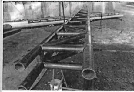
Fotos 3: Montaje de viguetas transversales y longitudinales
