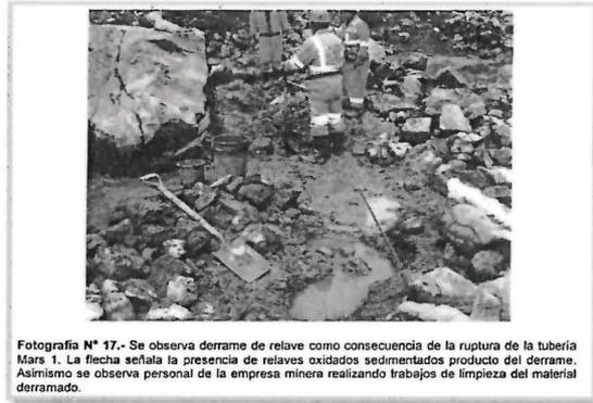
Fotografía N° 17.- Se observa derrame de relave como consecuencia de la ruptura de la tubería Mars 1. La flecha señala la presencia de relaves oxidados sedimentados producto del derrame. Asimismo se observa personal de la empresa minera realizando trabajos de limpieza del material derramado.
