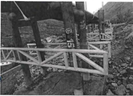
Fotos 4: Montaje de viguetas transversales y longitudinales
