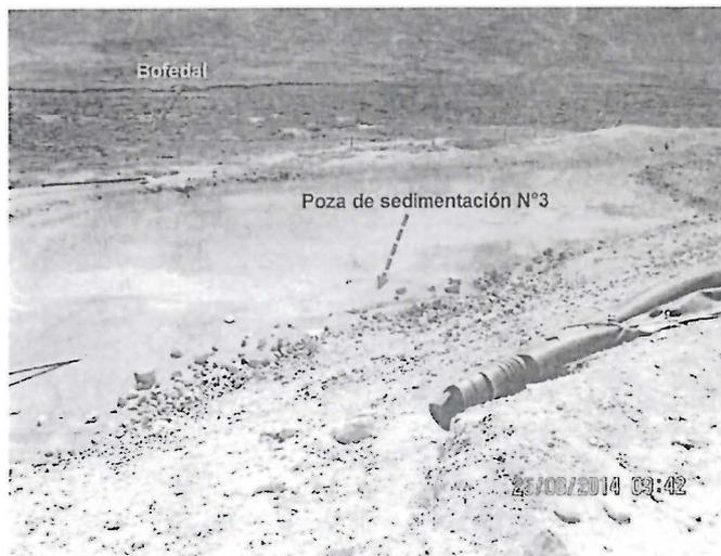
**Fotografía N° 66:** Hallazgo N° 4, Supervisión Regular Agosto 2014, Vista de la poza N°3 antigua de sedimentación de aguas de mina sobre terreno natural y construido en el depósito de desmontes de bocamina El Palomo Nv. 710. Se emplaza sobre el bofedal en la quebrada Chiccchilla.
