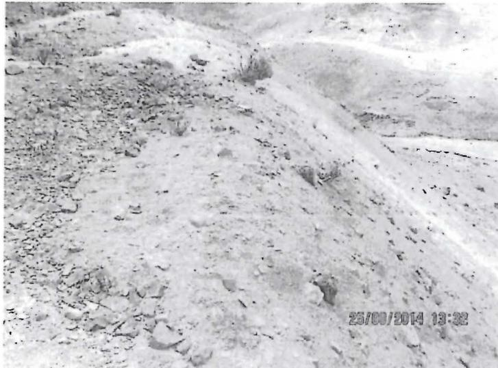
Fotografía N° 96: Hallazgo N° 7, Supervisión Regular Agosto 2014, Depósito de desmontes de la bocamina N°3. No tiene estructuras hidráulicas y se ubica sobre el bofedal en la quebrada Millupata.
