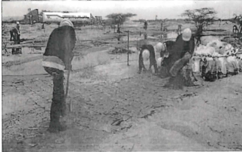
Se observa el crudo sacado en "bloqueitas", pues solo llegó hasta unos 8 cm. debido a la impermeabilidad del suelo
