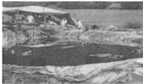
Fotografía N° 7: vista cercana de una poza de recuperación, se observa sólo el petróleo crudo que quedó en la poza
