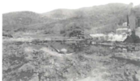
Fotografía N° 5: Vista personal realizando el bombeo del petróleo crudo y agua recuperados desde una poza a una cisterna.
