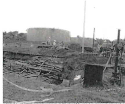
Foto N° 9. Fosa excavada con motivo de un incidente ocurrido en diciembre de 2011. Al fondo puede observarse la retroexcavadora con la que se abrió la fosa y los operarios para atender el incidente ocurrido el 30.06.2014. Asimismo, se distingue la manguera que desfoga el agua proveniente de la fosa del incidente.
