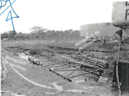
Foto N° 10. Vista de un segundo ángulo de la fosa excavada con motivo de un incidente ocurrido en diciembre de 2011. Las aguas acumuladas en la fosas del incidente se bombeaba a este lugar, puede observarse las mangueras de bombeo de entrada y de salida de agua con trazas de hidrocarburo.
