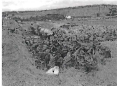
Fotografía N° 6 Saco de polietileno mezclado con hidrocarburos y colocando en sacos de polietileno
