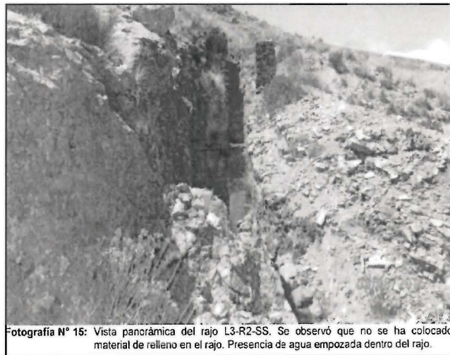
Fotografía N° 12: Vista frontal del rajo L3-R1-SS, ubicado en las coordenadas UTM WGS-84 (Z18) N 8913014; E 227713. Se observó que no se ha colocado material de relleno en el rajo. Presencia de agua empozada dentro del rajo.
