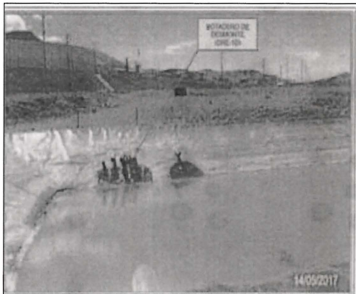
Fotografía N° 34: Se observó que el agua proveniente del sistema de subdrenaje del Depósito de Desmonte (DER-1D) descargaba sobre la poza de monitoreo.
