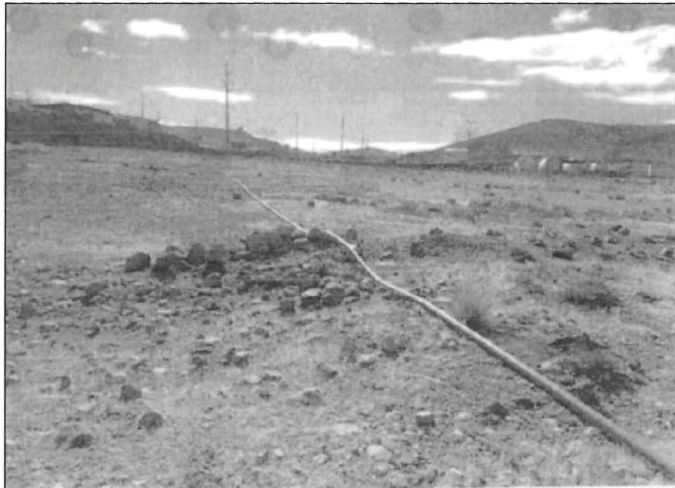
Fotografía N° 5: Recorrido de la manguera flexible de 2 pulgadas hacia la Planta de Tratamiento de Aguas Ácidas.
