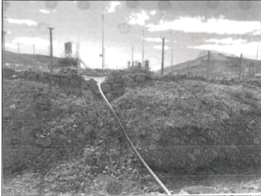
Fotografía N° 6: Recorrido de la manguera flexible de 2 pulgadas hacia la Planta de Tratamiento de Aguas Ácidas.
