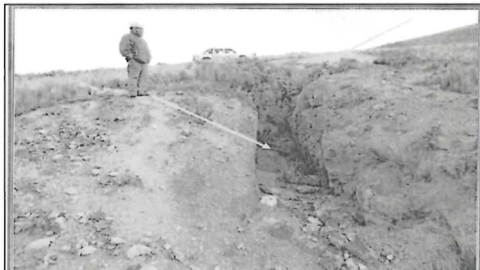
Fotografía N° 24: Zona Florida: Rajo y depósito de desmonte ubicados en las coordenadas UTM WGS 84: 227964E, 8915647N y 227969E, 8915662N. Se constató que no se realizó las actividades propuestas en el plan de cierre de los pasivos ambientales mineros de la unidad minera Lincuna Dos. (Acta de Supervisión – Componentes verificados, ítem 14 v 15). Hallazgo 1.
