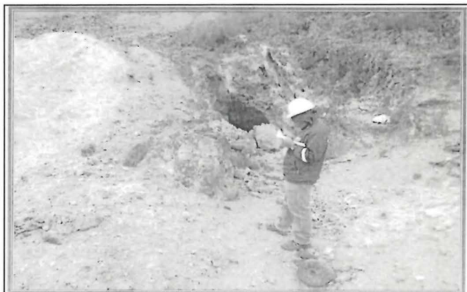
Fotografía N° 91: Zona Collaracra: Bocamina y botadero de desmonte ubicada en las coordenadas UTM WGS 84 226162E, 8918510N y 226179E, 8918594N. Se constató que no se realizaron las actividades propuestas en el plan de cierre de los pasivos ambientales mineros de la unidad minera Lincuna Dos. (Acta de Supervisión – Componentes verificados, ítem 56 y 57). Hallazgo 1
