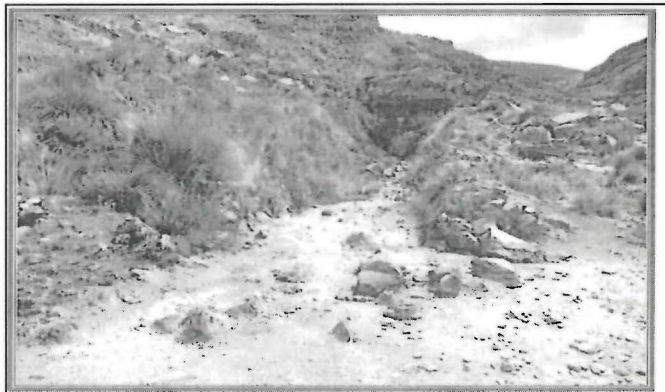
Fotografía N° 77: Zona Collaracra: Bocamina, ubicada en la margen derecha de la quebrada Don Julio, que es un tributario de la quebrada Collaracra, en las coordenadas UTM WGS 84: 226453E y 8918416N. Se constató que no se realizó las actividades propuestas en el plan de cierre de los pasivos ambientales mineros de la unidad minera Lincuna Dos. (Acta de Supervisión – Componentes verificados, ítem 47). Hallazgo 1 y 6.
