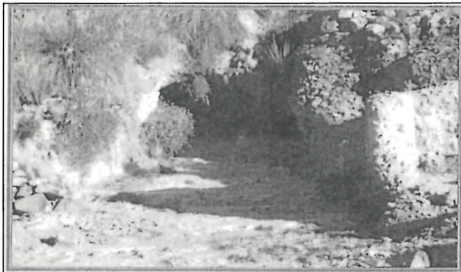
Fotografía N° 41: Zona Collaracra: En la Bocamina Don Pedro L2-B25-CL, ubicada en la margen izquierda de la quebrada Colca Racra, en las coordenadas UTM WGS 84: 227280E y 8918549N, se constató la existencia de un drenaje de agua ácida (Hallazgo 4) y no se realizó las actividades propuestas en el plan de cierre de los pasivos ambientales mineros de la unidad minera Lincuna Dos. (Acta de Supervisión – Componentes verificados, ítem 30). Hallazgo 1.
