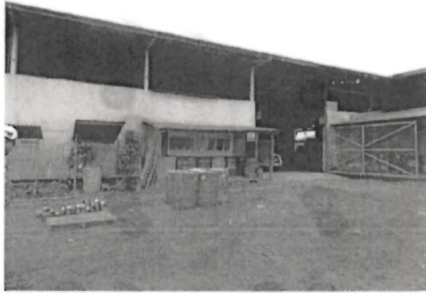
Foto N° 3. En el Taller Mecánico de Andoas, área de overhaul cerca al punto verde, se detectó cinco cilindros de aceite dispuestos en un área sin impermeabilizar y sin contención de derrames. Coordenadas UTM (WGS84) 340612E 9689154N
