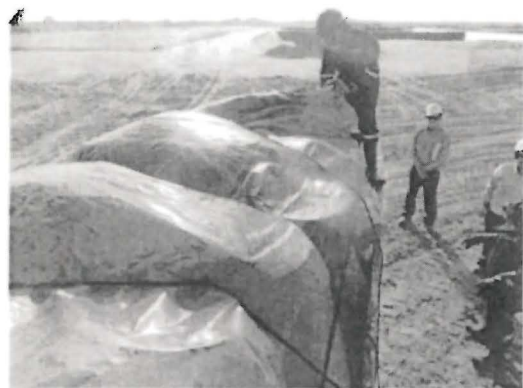
Foto N° 25: Relleno de Seguridad Milla Seis Transporte de residuos peligrosos desde Refinería Talara al Relleno Milla seis.
