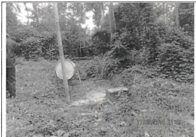
Fotografía N° 51: N 9023745, E 530519 / Planta de tratamiento de aguas residuales domésticas: opera al lado noreste del campamento.
