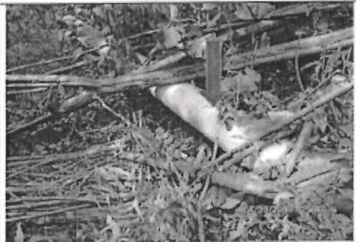
**Fotografía N° 8. Punto de falla donde se originó el derrame – Km 53+939. Línea B de 10" Corrientes - Saramuro colocado sobre el terreno firme, rodeado de vegetación. Se verifica tubería reparada (reemplazo). A nivel superficial no se advierte presencia de hidrocarburos sobre el derecho de vía.**
