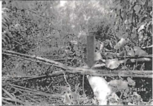
**Fotografía N° 8-A. Punto de falla donde se originó el derrame – Km 53+939. Línea B de 10" Corrientes - Saramuro colocado sobre el terreno firme, rodeado de vegetación. Se verifica tubería reparada (reemplazo). A nivel superficial no se advierte presencia de hidrocarburos sobre el derecho de vía.**
