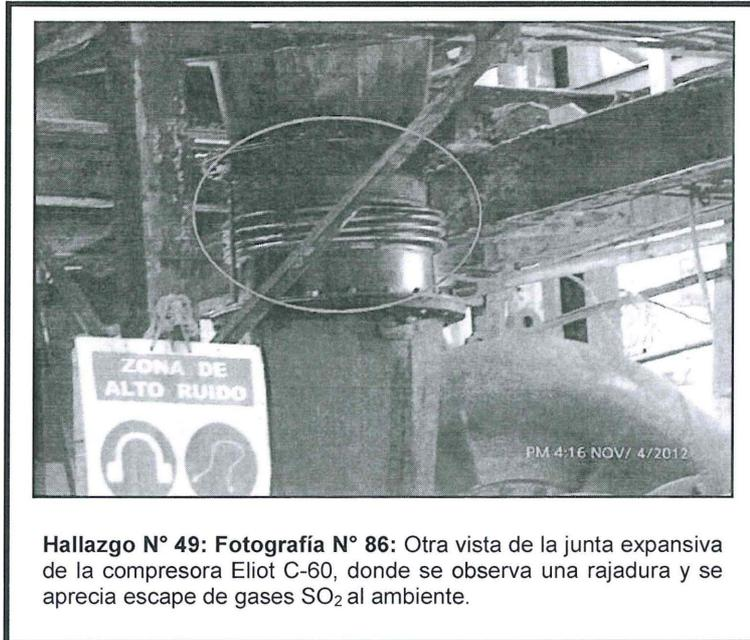
**Hallazgo N° 49: Fotografía N° 86:** Otra vista de la junta expansiva de la compresora Eliot C-60, donde se observa una rajadura y se aprecia escape de gases SO<sub>2</sub> al ambiente.
