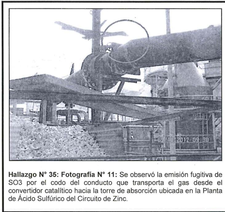
**Hallazgo N° 35: Fotografía N° 11:** Se observó la emisión fugitiva de SO<sub>3</sub> por el codo del conducto que transporta el gas desde el convertidor catalítico hacia la torre de absorción ubicada en la Planta de Ácido Sulfúrico del Circuito de Zinc.
