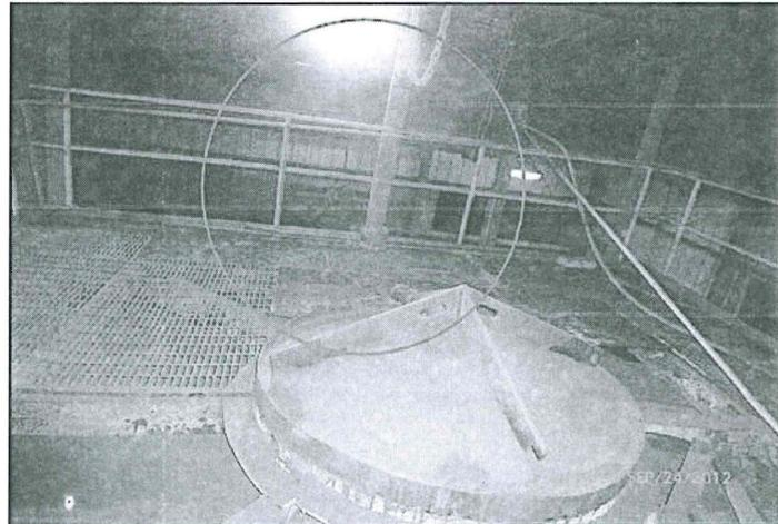
**Hallazgo N° 22: Fotografía N° 7:** En la parte superior del tostador Lurgi (TLR), se observa emisiones fugitivas de gases de SO<sub>2</sub> al ambiente, situado en el circuito de zinc.
