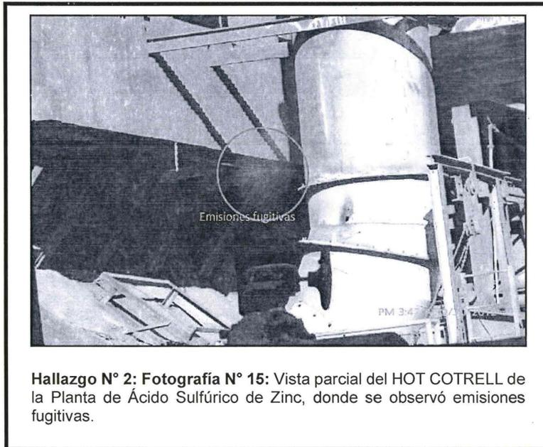
**Hallazgo N° 2: Fotografía N° 15:** Vista parcial del HOT COTRELL de la Planta de Ácido Sulfúrico de Zinc, donde se observó emisiones fugitivas.
