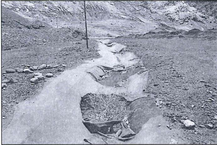
**Hallazgo N° 56: Fotografía N° 12:** En el canal para aguas de escorrentía de lluvias a un costado de la vía de acceso hacia el depósito de ferritas de Zinc de Huanchán, la geomembrana se encuentra en mal estado (rota) en ciertos tramos y además falta limpieza.
