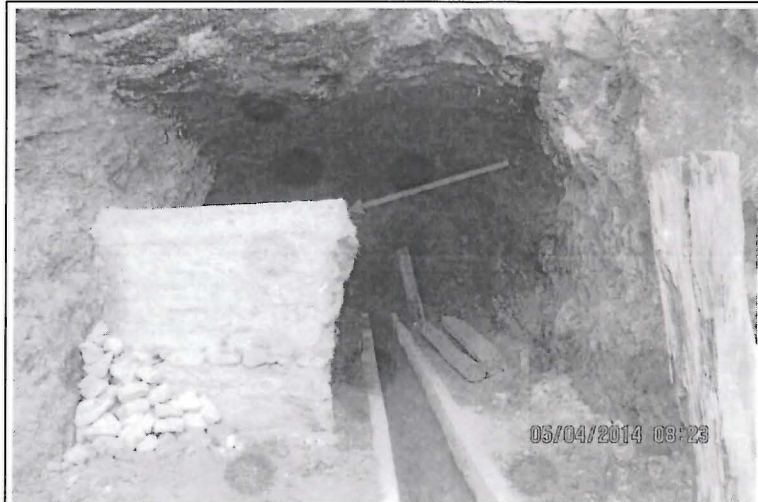
FOTO N° 4: Bocamina, donde se observa la construcción de una barrera de adobe y el canal por donde sale el efluente.
