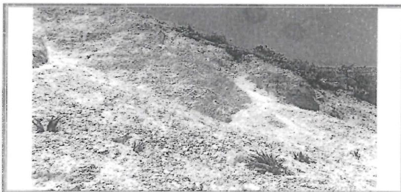
FOTOGRAFIA N° 32.- El talud colindante a dicha plataforma de perforación ANT-68, no se encuentra debidamente perfilado
