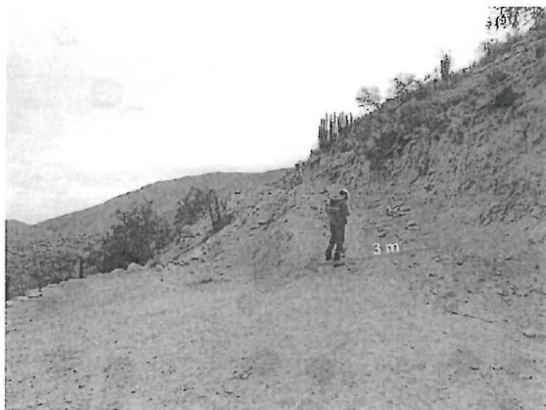
Fotografía N° 010: Ancho de acceso – Progresiva 1 + 000 (parte final del acceso) adyacente a plataforma de perforación 03. Vista tomada a los 1000 m de recorrido del acceso.
