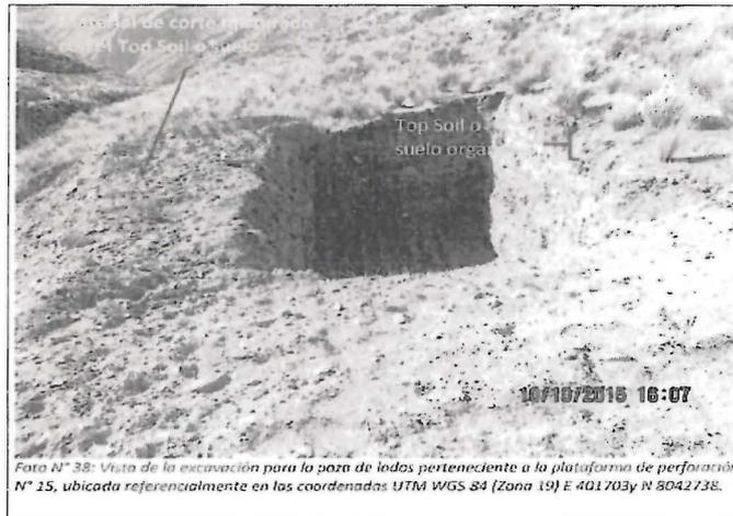
Foto N° 38: Vista de la excavación para la poza de lodos perteneciente a la plataforma de perforación N° 15, ubicada referencialmente en las coordenadas UTM WGS 84 (Zona 19) E 401703y N 8042738.
