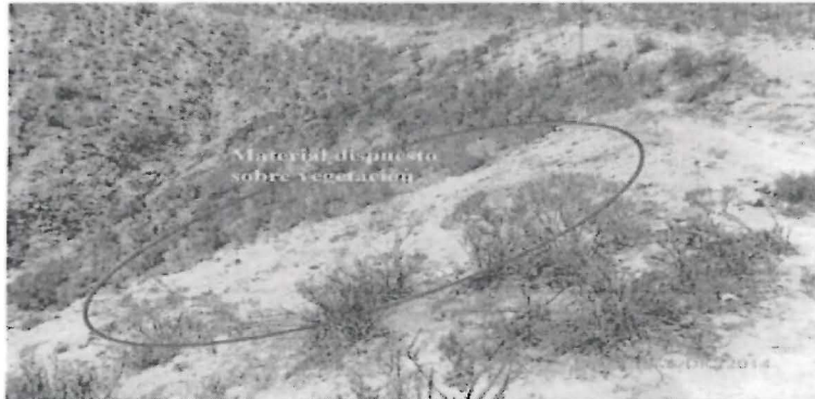
Fotografía N° 29: Plataforma con dos sondajes codificados como BDC 03 y BDC 04. Se aprecia que el material de desbroce se ha dispuesto sobre la ladera cubierta de vegetación.
