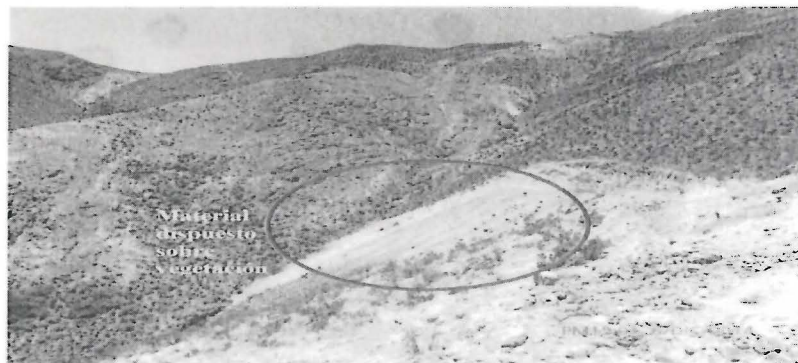
Fotografía N° 25: Plataforma sin bloque de cemento ubicada en las coordenadas UTM Datum WGS-84 9 092370N, 764872E. Asimismo en la parte baja de la plataforma también existe material (suelo y rocas) dispuesto sobre la vegetación de la zona.
