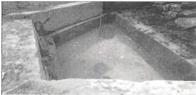
Fotografía N° 1: Hallazgo 10.- Se construyó otra poza de sedimentación de lodos, el vertimiento de esta poza sale a una poza donde se sedimentan los sólidos remanentes para luego recién ser evacuada por una tubería hacia la laguna Rupahuay como cuerpo receptor.
