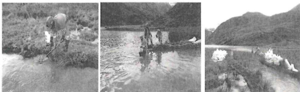
Fotografías N° 2: Hallazgo 11.- Se realizó la limpieza de los sedimentos acumulados en el margen del canal de descarga e ingreso a la laguna Rupahuay.
