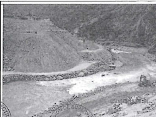
Vista 13. DME-B2 Yanarumi, parte aguas abajo, sin disposición en forma de banquetas, perfilado, sistemas de drenaje y, con pendientes mayores de 1,5:1 (H:V).
