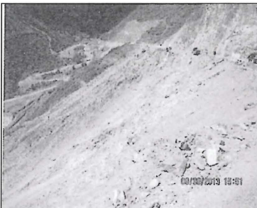
Vista 7. Tramo con material excedente dejado hacia abajo del acceso.
