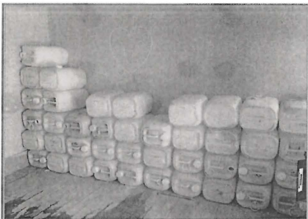
FOTOGRAFÍA N° 95.- Hallazgo N° 6: Envases peligrosos dispuestos sobre piso de madera (no impermeable), además se observa manchas de humedad por escurrimiento de agua de precipitación hacia los pisos.
