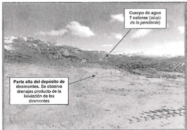
FOTOGRAFÍA N° 122.- Hallazgo N° 11: Drenajes de los desmontes acumulados.
