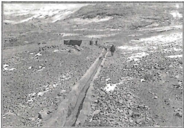
FOTOGRAFÍA N° 126.- Hallazgo N° 12: Canal de derivación de aguas de mina de bocamina Benevento hasta tanques de cal y floculantes.
