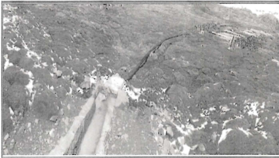
FOTOGRAFÍA N° 129.- Hallazgo N° 12: Fin del canal que traslada agua de mina con cal y floculantes. Esta agua es transportada por tubería hacia las pozas de sedimentación. Se pide observar que parte del agua tratada se escurre y se vierte a los bofedales.
