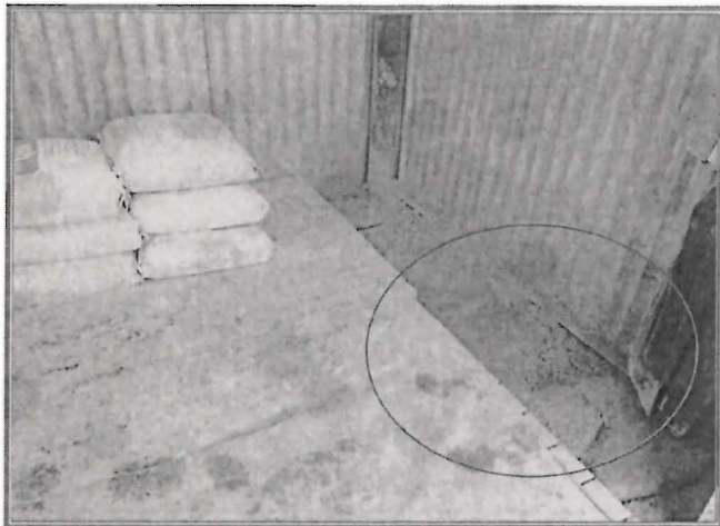
FOTOGRAFÍA N° 91.- Hallazgo N° 5: Sacos de cal ubicados sobre parrillas forradas de plástico. Se observa que el piso no es impermeable.
