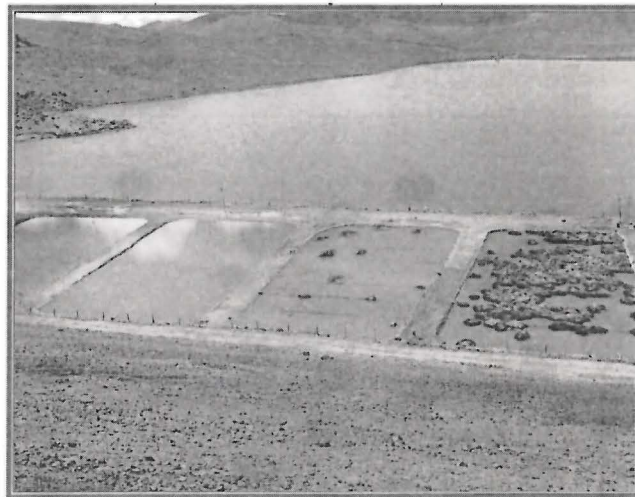
FOTOGRAFIA N° 84.- Hallazgo N° 4.- Sistema de tratamiento pasivo de agua de proveniente de los relaves (wetland), ubicado en coordenadas 8 541 086 N, 483 771 E. Este sistema no se encuentra contemplado en los instrumentos de gestión ambiental.
