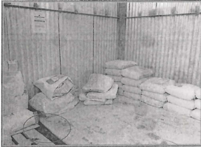
FOTOGRAFÍA N° 90.- Hallazgo N° 5: Sacos de cal ubicados sobre parrillas forradas de plástico. Se observa que el piso no es impermeable.
