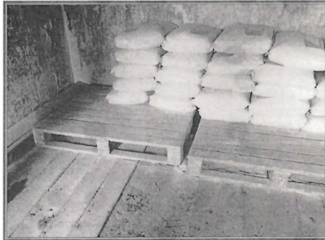
FOTOGRAFÍA N° 87.- Hallazgo N°5: Se observa los sacos de cal sobre parrillas de madera y la base del depósito conformado por madera. Se observa el piso de madera roto y con manchas notorias de cal.
