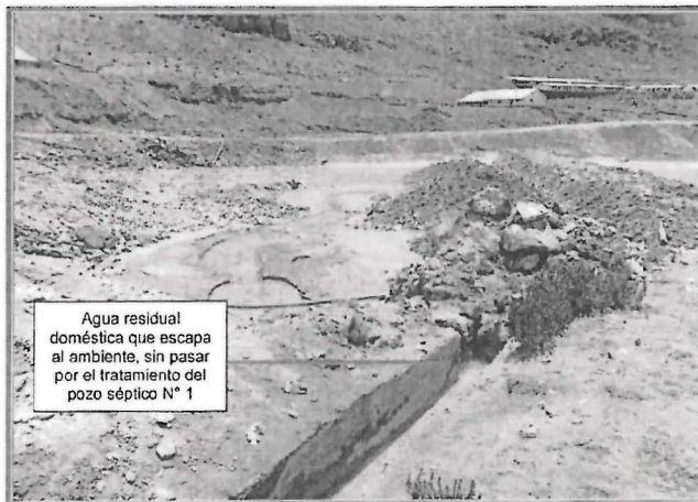
FOTOGRAFIA N° 104.- Agua residual doméstica que escapa al ambiente, sin pasar por el tratamiento del pozo séptico
