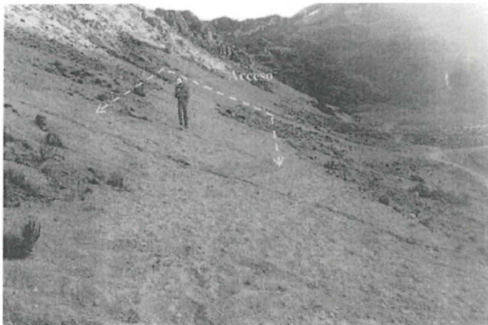
Fotografía N° 123: Acceso hacia las plataformas P 09 y P10, se encontraba perfilado. Asimismo, se observó que dicho acceso no contaba con presencia de vegetación y presentaba rocas sueltas.
