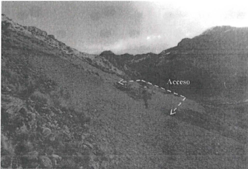
Fotografía N° 124: Acceso hacia las plataformas P 09 y P10, se encontraba perfilado. Asimismo, se observó que dicho acceso no contaba con presencia de vegetación y presentaba rocas sueltas.
