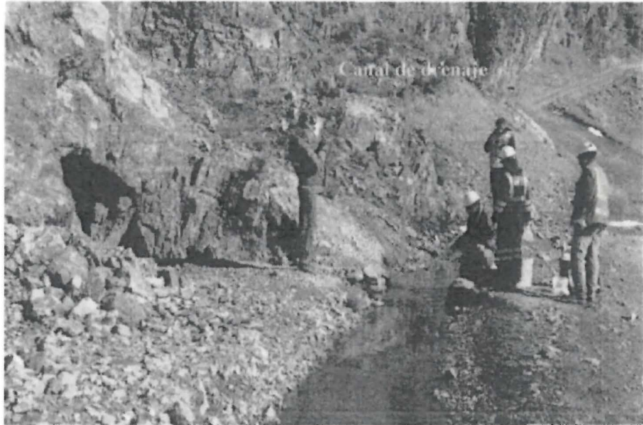
Fotografía N° 018: Bocamina - Plat Que 56, presentaba una pared de piedra y concreto. Asimismo, contaba con una tapa metálica abierta en el medio de dicha pared. Por otro lado se verificó un canal de drenaje construido de piedras, desde donde discurría agua desde el interior de la bocamina, infiltrándose por la superficie del terreno al final de dicha cuneta.
