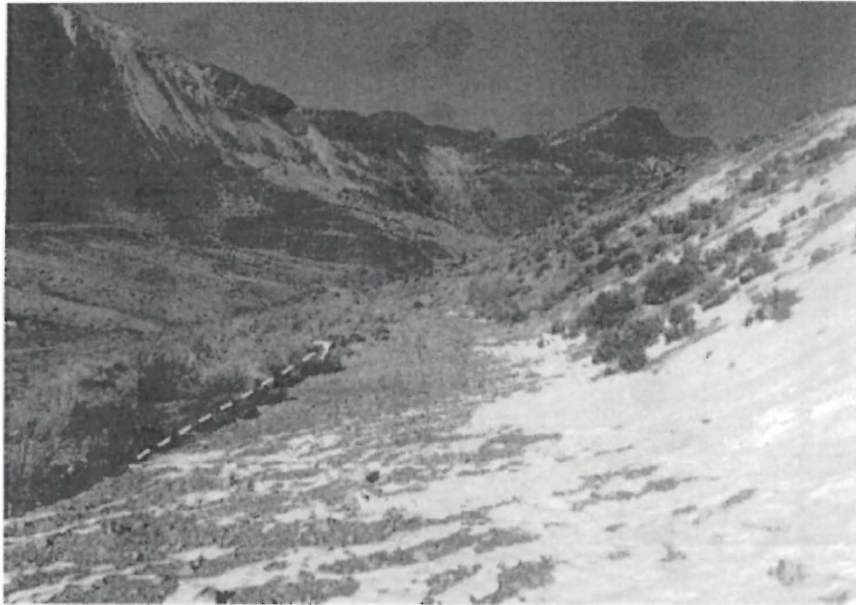
Fotografía N° 007: Acceso a la Plataforma de perforación P-12, no se encontraba perfilado ni revegetado. Asimismo, se observó que dicho acceso presentaba rocas sueltas.
