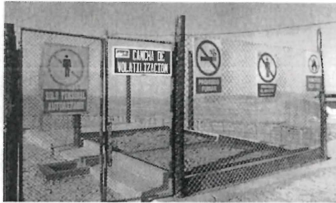
Cancha de Volatilización con su respectiva señalización y cercado
