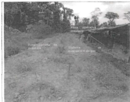
**Fotografía N° 1: Fosa de Residuos.** Obsérvese, que la empresa ha cerrado una fosa de residuos y asimismo viene operando otra fosa.
