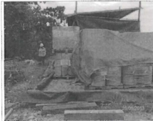
**Fotografía N° 9:** Vista del área de almacenamiento de productos químicos y/o lubricantes en EPC30, observese que los productos se encuentra a la intemperie, expuestos a las lluvias y sólo cuenta con un sistema de contención (pít inadecuadamente construido, el almacenamiento sobrepasa la capacidad).
