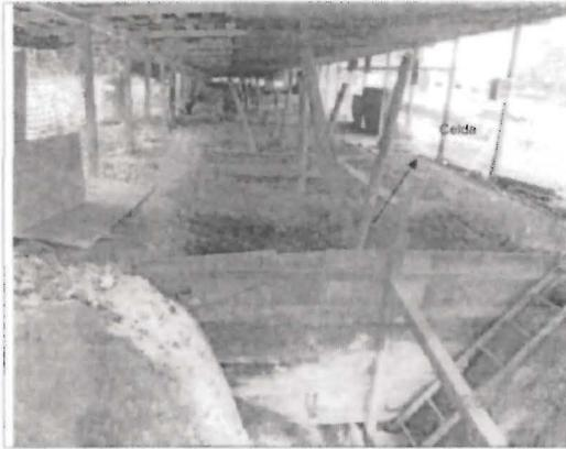
**Fotografía N° 2:** Fosa de Residuo. Obsérvese que la fosa de residuos tan como lo indica el EIA se encuentra techada, cercada y está compuesta de celdas. Sin embargo, se detectó que las fosas no se encuentran impermeabilizadas
