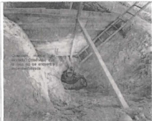
**Fotografía N° 3:** Fosa de Residuos. Obsérvese que la fosa no se encuentra impermeabilizada y así mismo se constató la colección manual de lixivados. Cabe precisar, que la colección de lixiviado sería optima si las celdas que conforman la fosa estarían impermeabilizadas.
