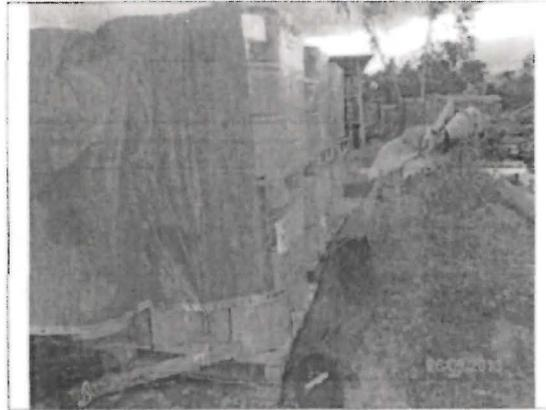
Fotografía N° 10: Vista del área de almacenamiento de productos químicos y/o lubricantes en EPC30, obsérvese que los productos se encuentran a la intemperie, expuestos a las lluvias y sólo cuenta con un sistema de contención (pit inadecuadamente construido, el almacenamiento sobrepasa la capacidad).
