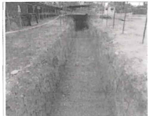
**Fotografía N° 4:** Vista de la apertura de una nueva fosa de residuos contigua a la fosa operativa. En dicho lugar no se encontró un pozo de monitoreo de agua subterránea.
