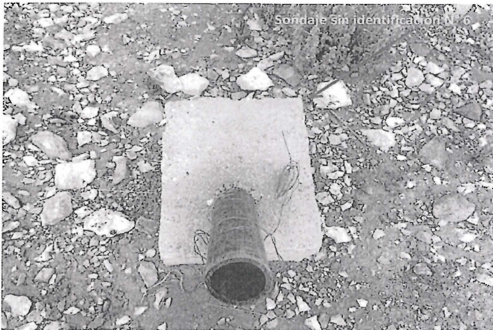
Fotografía N° 038: Dado de concreto indicador de un sondaje en la plataforma de perforación HUA 10-003. Nótese la ausencia de identificación del sondaje.
