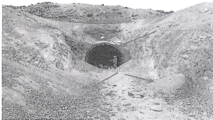
Fotografía N° 028: Vista del material apilado producto de la construcción de dicha labor subterránea.
