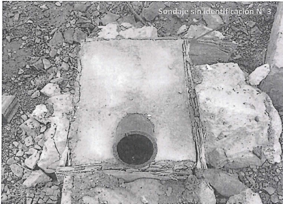
Fotografía N° 034: Dado de concreto indicador de un sondaje en la plataforma de perforación HUA 10-004. Nótese la ausencia de identificación del sondaje.
