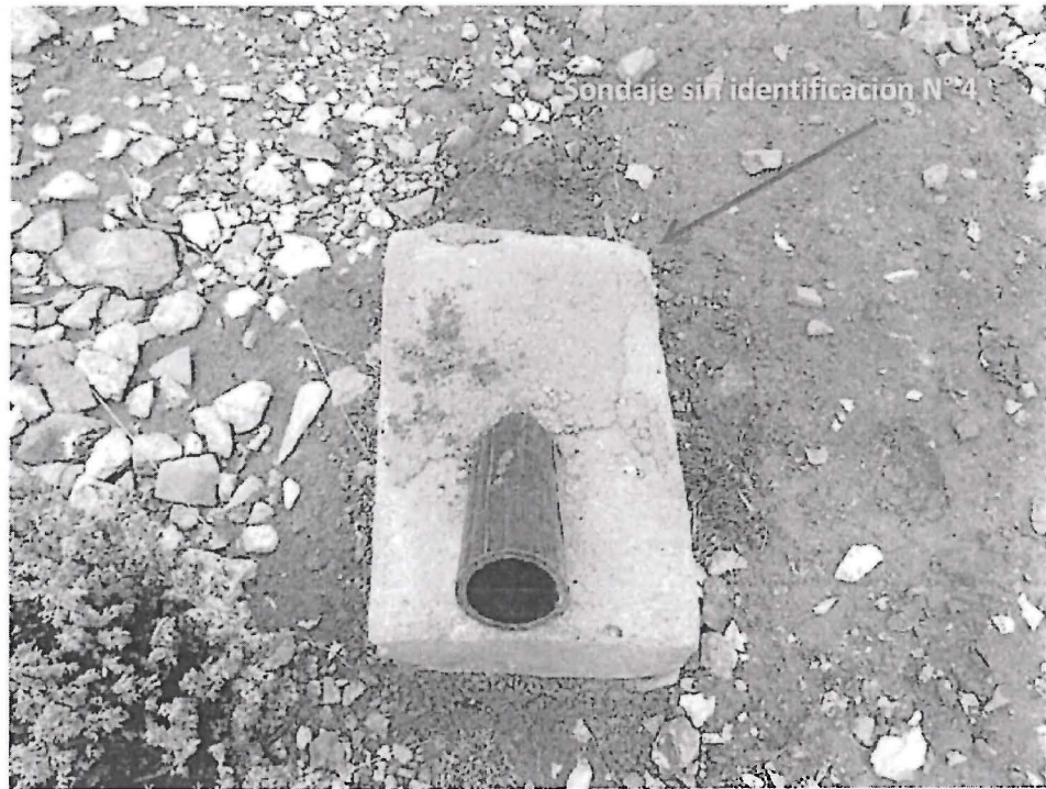
Fotografía N° 036: Dado de concreto indicador de un sondaje en la plataforma de perforación HUA 10-003. Nótese la ausencia de identificación del sondaje.
