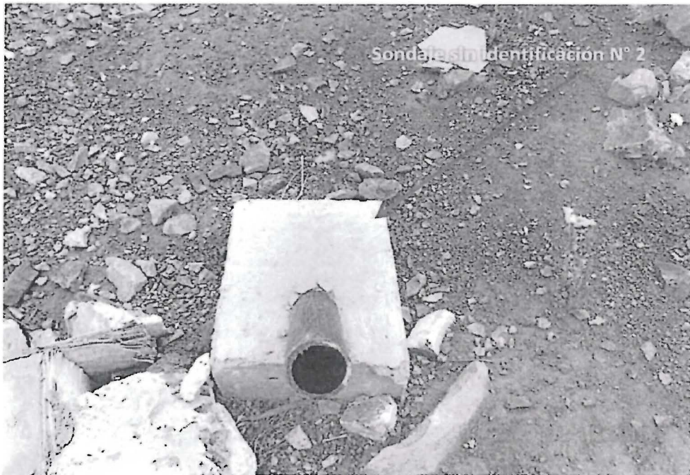
Fotografía N° 033: Dado de concreto indicador de un sondaje en la plataforma de perforación HUA 10-004. Nótese la ausencia de identificación del sondaje.
