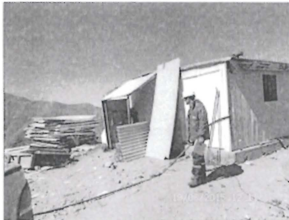
FOTOGRAFIA N° 14: Vista del campamento. Ubicado en coordenadas UTM 8270000N 6187455E Datum WGS-84, zona 18 S.
