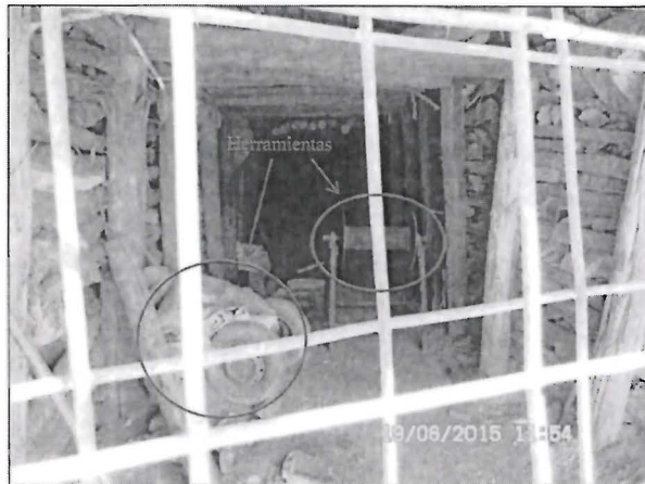
FOTOGRAFÍA N° 13: Vista del detalle de las herramientas que por detrás de las rejas que impiden el ingreso a la bocamina denominada Labor Paralizada N° 2.
