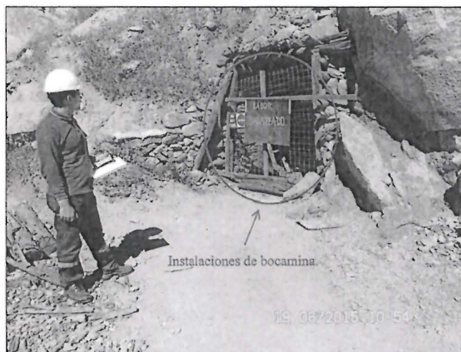
FOTOGRAFIA N° 2: Vista de la bocamina Nv. 2800 denominada como "Veta Lomo Nv. 2800". Ubicado en coordenadas UTM 8270037N 618831E Datum WGS-84, zona 18 S.
