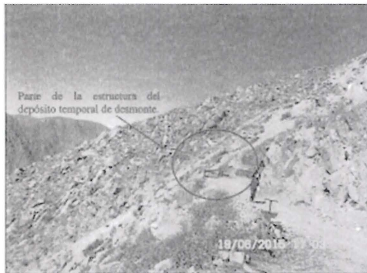
FOTOGRAFIA N° 5: Vista de partes de la estructura del depósito temporal de desmonte al pie de la bocamina NV. 2800.
