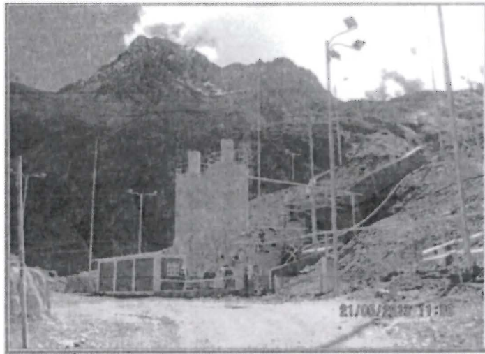
FOTOGRAFIA N° 463. - A la altura del Nivel 4320 de la zona Riqueza (bocamina operativa) se constató la existencia de la Planta de Relleno Hidráulico. Esta infraestructura no está contemplada en el EIA. Planta de relleno hidráulico, coordenadas UTM datum WGS84: 8 901 885 N, 275 113 E y 4 344 msnm. Hallazgo N° 21 – 2013.
