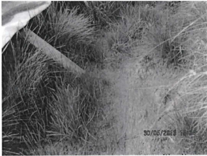
Fotografía N° 52: Relaves sobre suelo natural en la margen izquierda del canal de geomembrana.
