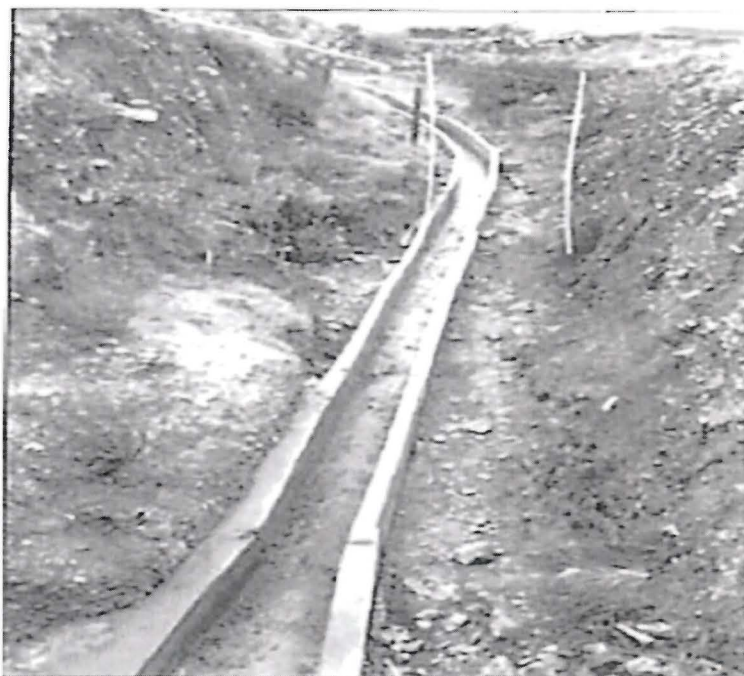
Se observa canal de concreto que reemplaza a canal de geomembrana Sin presencia de lodos en las zonas adyacentes
