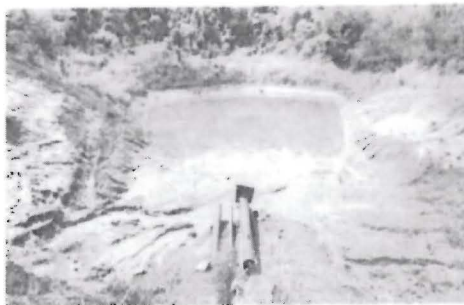
Fotografía N° 09. Locación San Martín 3 Fosa de quemado de gas natural en caso emergencias. la foto fue tomada en mayo de 2013
