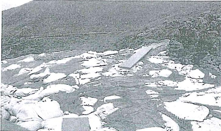
Fotografía N° 42: Hallazgo 1. En las zonas donde se almacenan los sacos con lodos en el sector Azalia, los sacos que se encuentran en la parte superior están rotos. Los lodos se encuentran expuestos al ambiente.
