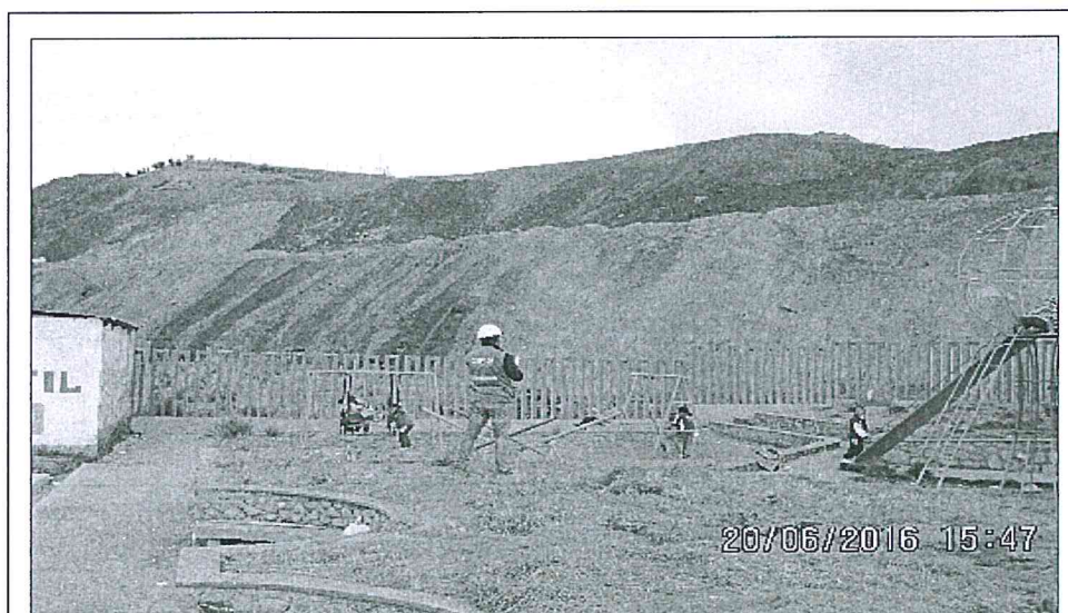
Fotografía N° 1.- Vista del interior del Parque Infantil. Se observa niños jugando en este. Asimismo, se observa el muro que delimita con el stock pile de la Planta de Óxidos y parte del Depósito de Desmonte Miraflores correspondiente a Cerro SAC.
