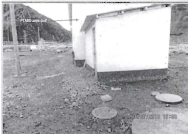
FOTOGRAFIA N° 321. Vista posterior de la planta de tratamiento de aguas residuales domésticas (PTARD) de la zona de Golf. La tubería con el efluente doméstico tratado llega a un buzón.
