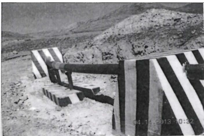
Fotografía N° 51: Vista de la línea de conducción de relaves del depósito de relaves N° 3, cercana a este depósito. Obsérvese que la tubería HDPE que transporta relaves está debidamente señalizada.
