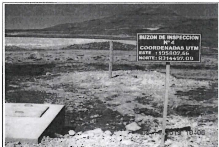
**Fotografía N° 48:** Vista de otro de los buzones de inspección de la línea de conducción de relaves enterrada del depósito de relaves N° 3. Obsérvese el cartel de identificación de este buzón.
