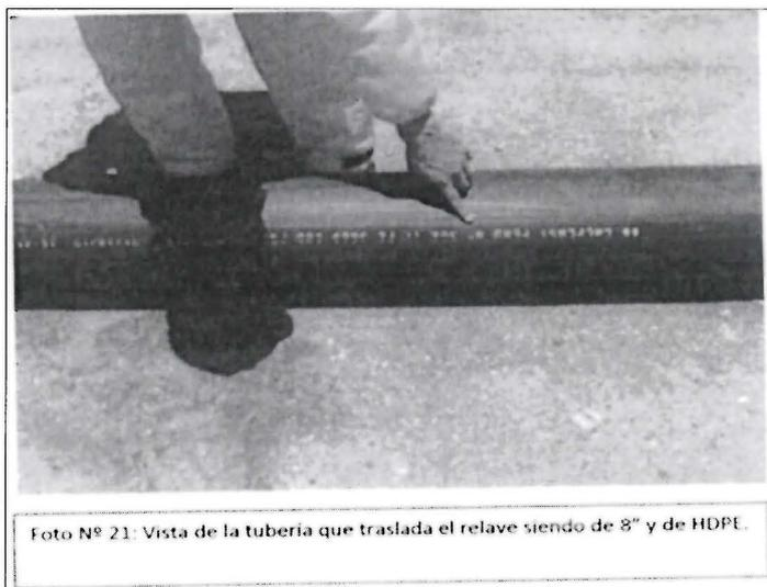
Foto N° 21: Vista de la tubería que traslada el relave siendo de 8” y de HDPE.
