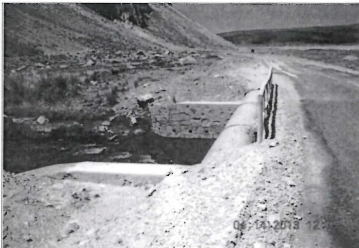
Fotografía N° 50: Vista de la línea de conducción de relaves del depósito de relaves N° 3, en el cruce con el río Santiago. Obsérvese que el tubo de fierro es la contención de la tubería que se encuentra en su interior (ante cualquier derrame de relaves) y que conduce los relaves hacia el depósito de relaves N° 3.
