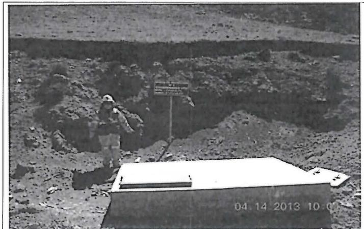
**Fotografía N° 47:** Vista de uno de los buzones de inspección de la línea de conducción de relaves enterrada del depósito de relaves N° 3. Obsérvese el cartel de identificación de este buzón.
