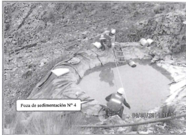
Fotografía N° 103: Vista de la poza de sedimentación N° 4 de la plataforma PLT-22 ubicado en la parte inferior respecto a las tres pozas de la fotografía anterior.
