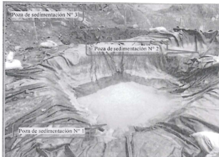
Fotografía N° 104: Vista de las 3 pozas de sedimentación de lodos de perforación que forman parte de la plataforma PLT-10, se puede evidenciar que la tercera poza no cuenta con revestimiento de material sintético.
