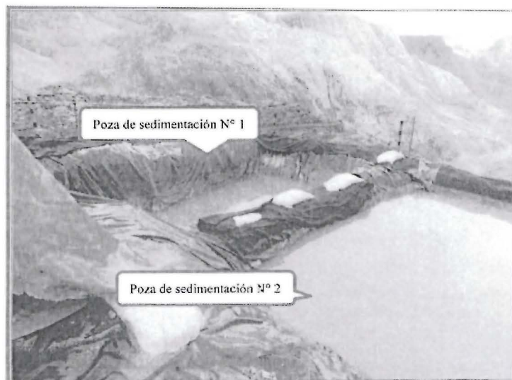
Fotografía N° 111: Vista de las dos primeras pozas de sedimentación de lodos de perforación en la plataforma PLT-16.
