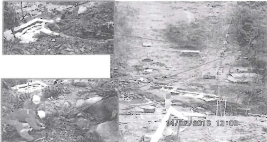
Se observa un afloramiento de agua en un punto del derecho de vía ubicado aproximadamente a 150 m cotas abajo del punto de falla donde se produjo el derrame; el agua que aflora, contiene trazas de hidrocarburos los que han sido canalizados a través de tuberías hasta las pozas de recuperación ubicadas en el DdV del STD en la margen izquierda de la quebrada Igoritoshian.
