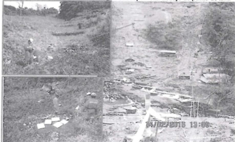
Se observa un afloramiento de agua en un punto del derecho de vía ubicado aproximadamente a 55 m cotas abajo del punto de falla donde se produjo el derrame; el agua que aflora, contiene trazas de hidrocarburos los que han sido canalizados a través de tuberías hasta las pozas de recuperación ubicadas en el DdV del STD en la margen izquierda de la quebrada Igoritoshian.
