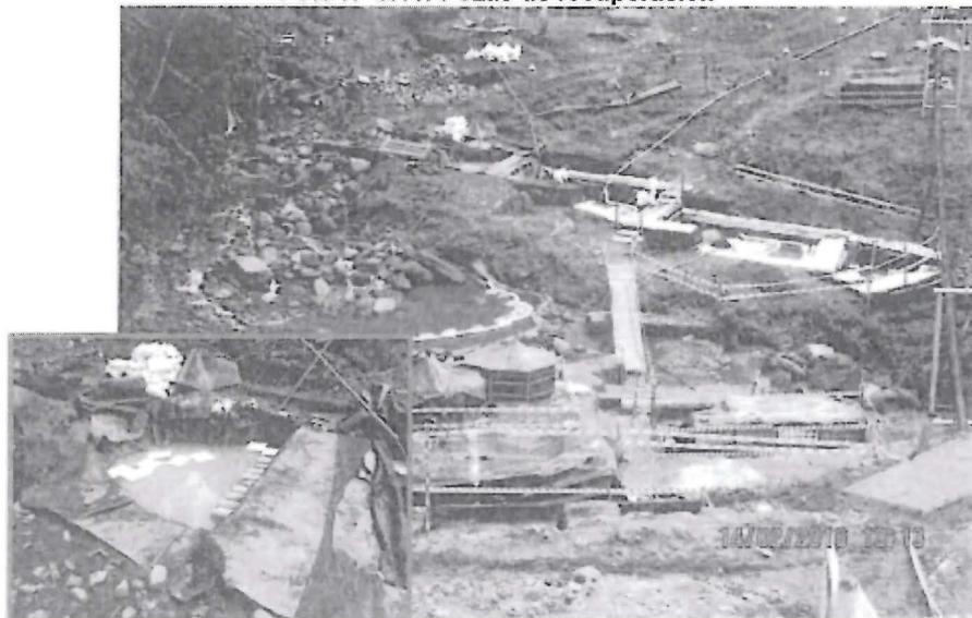
Se observa las pozas de recuperación, que están acondicionadas en la margen izquierda de la quebrada Igoritoshiari, entre los gaviones de protección de cauce del DdV del STD, impermeabilizadas con geomembrana, conformada por cuatro pozas en serie, interconectadas a través de codos de 4" que funcionan como trampas de grasa que evita el paso de sustancias oleosas de una poza a la siguiente.
