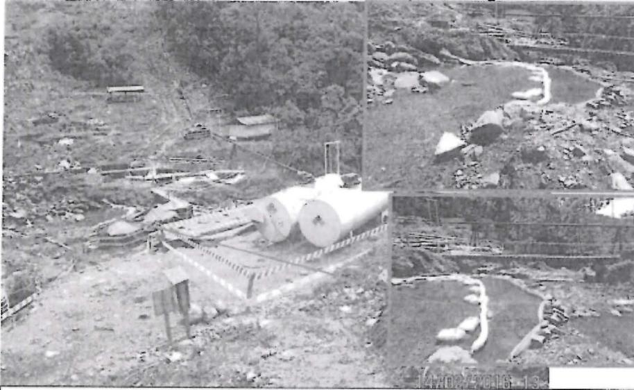
Se observa la barrera de contención que está ubicada en el cruce entre la quebrada y el DdV del STD Camisea aproximadamente en el KP 56+250; está conformado por un sistema de contención, conformado por barreras de contención para aguas rápidas combinadas con barreras oleofílicas.
