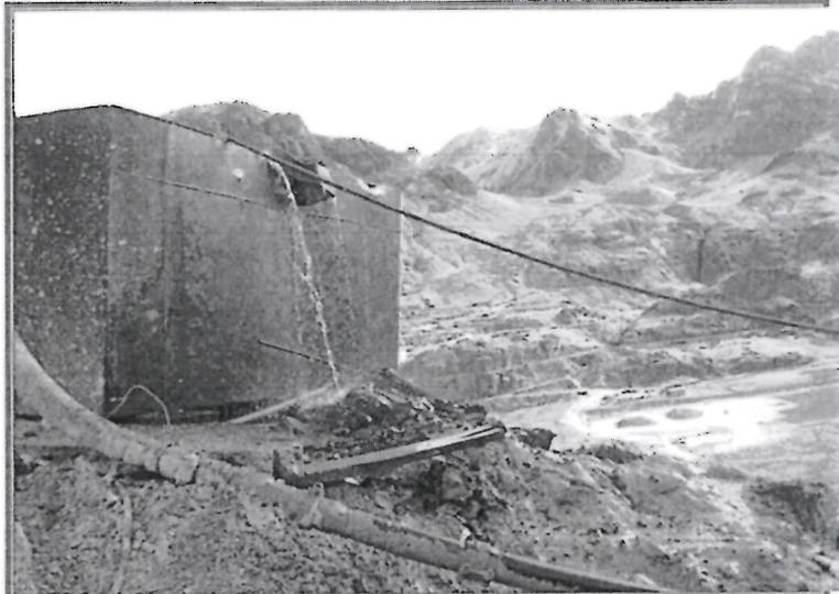
FOTOGRAFIA N° 65.- Falta de control de alimentación de agua al tanque de la bocamina "Recuay Alto" el agua penetra en el desmorte y erosiona acarreado material hacia terreno de pastos naturales.
