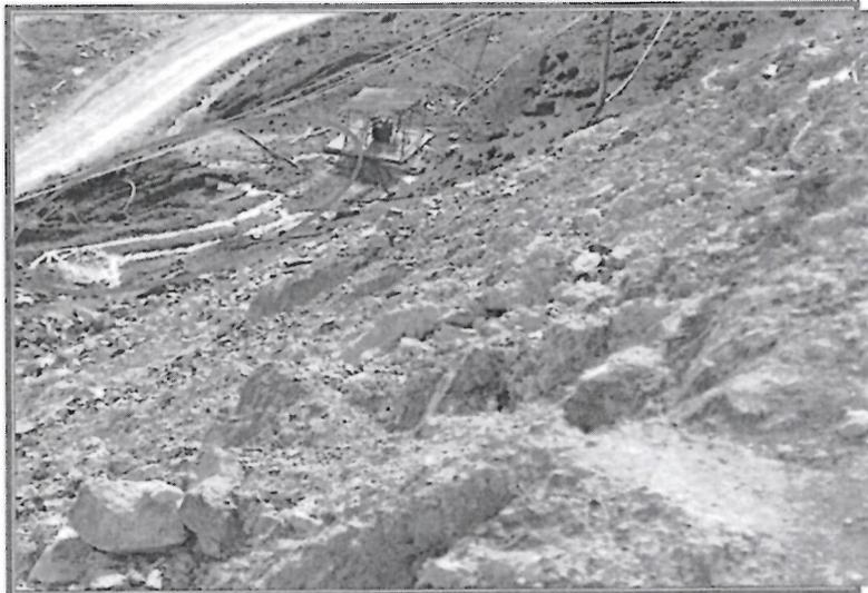
FOTOGRAFIA N° 66.- Se observa el agua de rebose del tanque en contacto con pastos ingresando a la cuneta de la vía.
