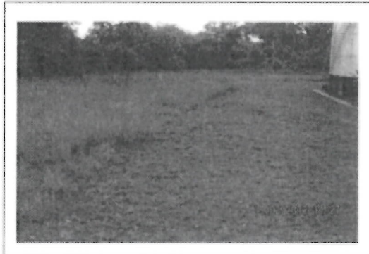
Descripción: Vista del Tanque 3 (Puerto Oriente) observase presencia de suelo y vegetación en la zona de estanca.
