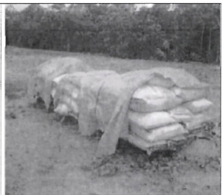
Fotografía N° 06: Ex campamento - Marsella - Lote 1AB Recipientes con sustancias químicas dispuestos sobre áreas sin sistema de contención secundaria, superficies no impermeabilizadas, y a la intemperie. Cantidad: 40 unid. (de 50 Kg. c/u)
