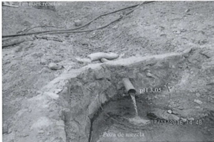
Fotografía N° 1.- Agua proveniente de los tanques reactores, que es captada en una poza acondicionada.
