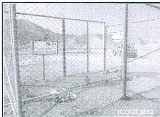
Fotografía N° 06: Vista del Pozo PB131 (sistema de gas lift), se observa plataforma de pozo sin sistema de contención de fugas y derrames.
