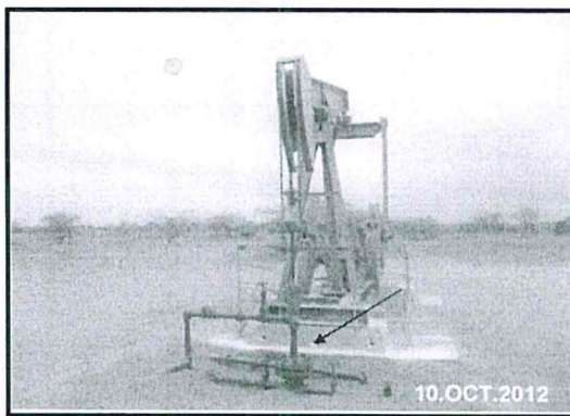
Fotografía N° 04: Vista de ubicación del Pozo 1360, se observa plataforma del pozo sin sistema de contención de fugas y derrames
