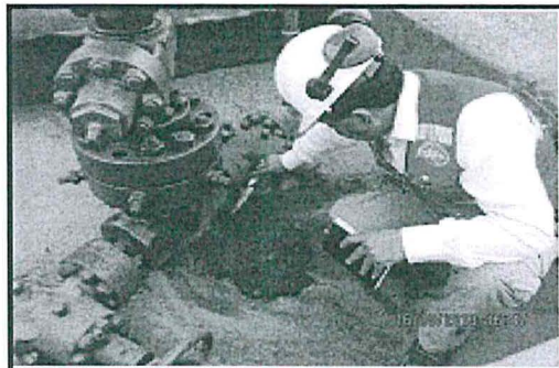
Fotografía N° 43: Pozo 6896, suelo contaminado en la cantina (SU-05:488831E, 9539875N)
