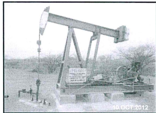
Fotografía N° 05: Vista de ubicación del Pozo 1587, se observa plataforma de pozo sin sistema de contención de fugas y derrames.
