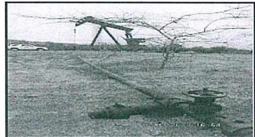
Fotografía N° 45: Pozo 6896, líquido fuera de la válvula a 15 metros del pozo (488850E, 9539834N)
