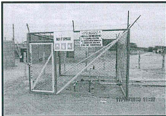
Fotografía N° 20: Pozo 1175, tipo gas lift, no presenta cantina ni geomembrana en el sector del puente de producción. El área del este pozo está siendo ganado por la población aledaña (486864E, 9538695N)
