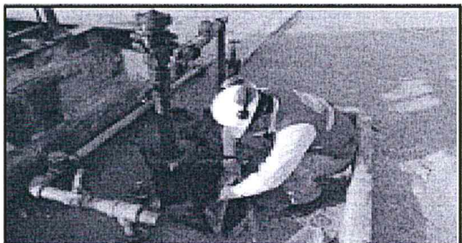
Fotografía N° 33: Pozo 12816, se observa lquero de hidrocarburos en varios puntos de la línea, a aproximadamente 50 metros del pozo (490228E, 9541000N)
