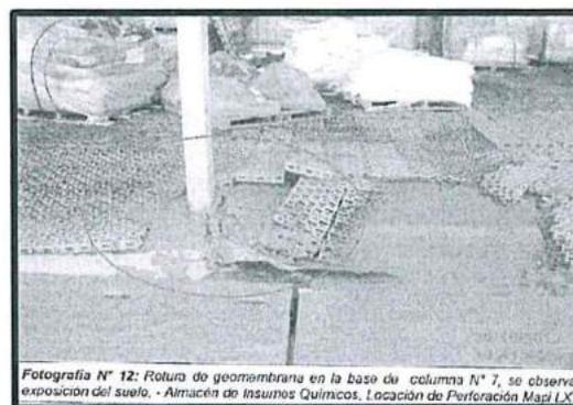
Fotografía N° 12: Rotura de geomembrana en la base de columna N° 7, se observa exposición del suelo. - Almacén de Insumos Químicos, Locación de Perforación Mapi LX.
