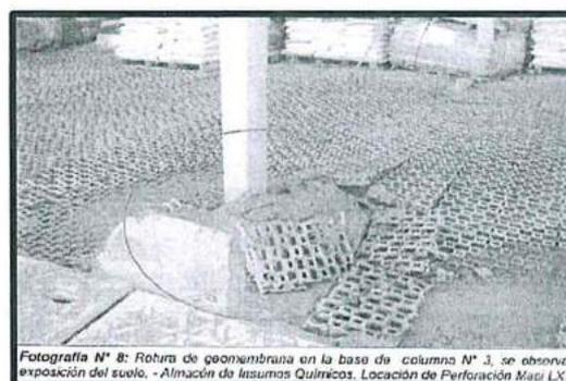
Fotografía N° 8: Rotura de geomembrana en la base de columna N° 3, se observa exposición del suelo. - Almacén de Insumos Químicos, Locación de Perforación Mapi LX.
