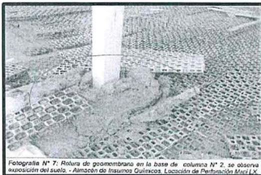
Fotografía N° 7: Rotura de geomembrana en la base de columna N° 2, se observa exposición del suelo. - Almacén de Insumos Químicos, Locación de Perforación Mapi LX.
