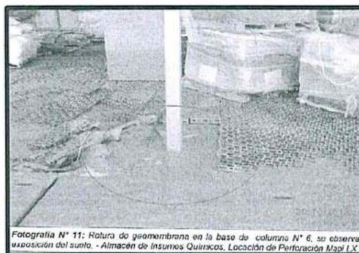
Fotografía N° 11: Rotura de geomembrana en la base de columna N° 6, se observa exposición del suelo. - Almacén de Insumos Químicos, Locación de Perforación Mapi LX.
