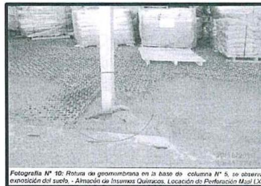
Fotografía N° 10: Rotura de geomembrana en la base de columna N° 5, se observa exposición del suelo. - Almacén de Insumos Químicos, Locación de Perforación Mapi LX.
