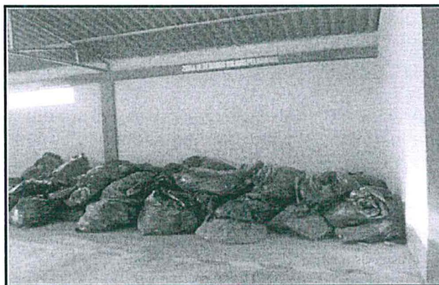
Fotografía N° 10: Centro de almacenamiento de residuos peligrosos, vista de almacenamiento de residuos peligrosos a granel en bolsas plásticas no identificadas. Al respecto, de acuerdo al Reglamento de Residuos el almacenamiento de residuos peligrosos deben ser en contenedores o recipientes.
