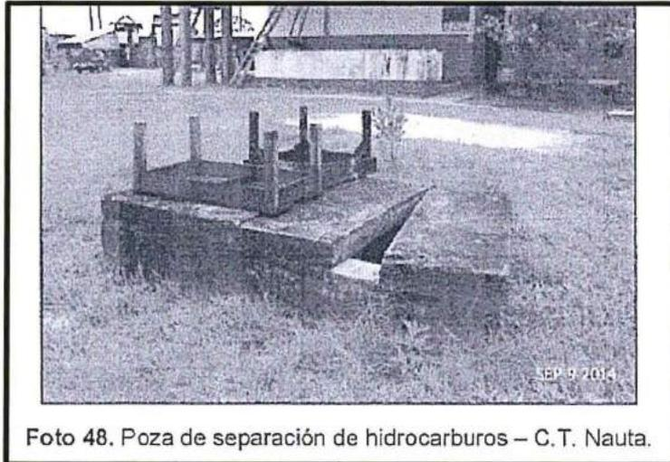
Foto 48. Poza de separación de hidrocarburos – C.T. Nauta.
