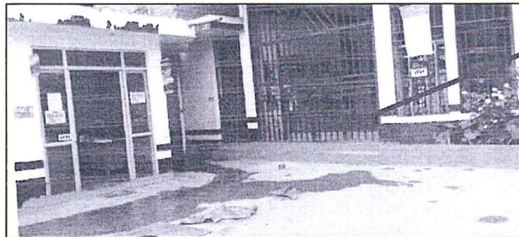
Sistema de contención
