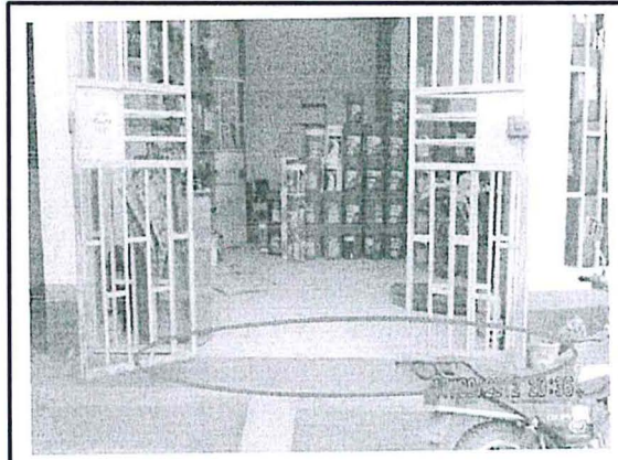
Foto N° 03: En el Puesto de Venta de Combustible – Grifo, Combustibles Ronaldo E.I.R.L., el área asignada para el almacenamiento de los lubricantes NO Cuenta con Sistema de Doble Contención.
