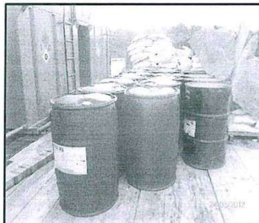
Fotografía N° 29: Plataforma 32X del Yacimiento de Yanayacu, vista de almacenamiento de productos químicos en áreas inadecuadas que no cuentan con sistema de contención de derrame y tampoco se encuentra impermeabilizada.
