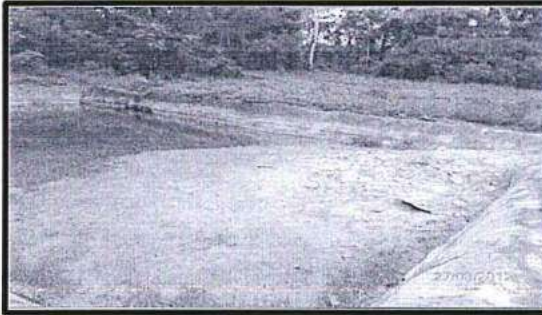
Fotografía N° 67: Vista centro de almacenamiento y disposición de lodos de perforación y recortes del Yacimiento Corrientes.
