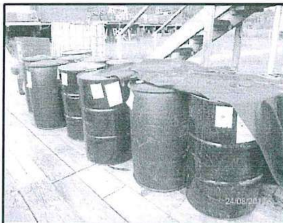
Fotografía N° 28: Plataforma 32X del Yacimiento de Yanayacu, vista de almacenamiento de productos químicos en áreas inadecuadas que no cuentan con sistema de contención de derrame y tampoco se encuentra impermeabilizada.
