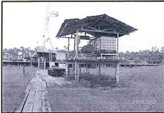
Fotografía N° 25: Vista del Inyector de Químicos de la Plataforma 32X del Yacimiento Yanayacu. En dicho lugar, debajo de la caseta se observó suelos afectados con hidrocarburos.
