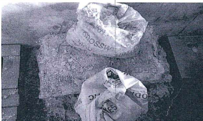
Fotografía 15. Producto químico (soda cáustica) exudado y derramado sobre el piso de concreto, cerca de otros productos químicos y de la llave de agua.
