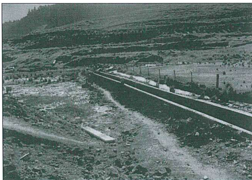
Se observa el canal en su etapa final
