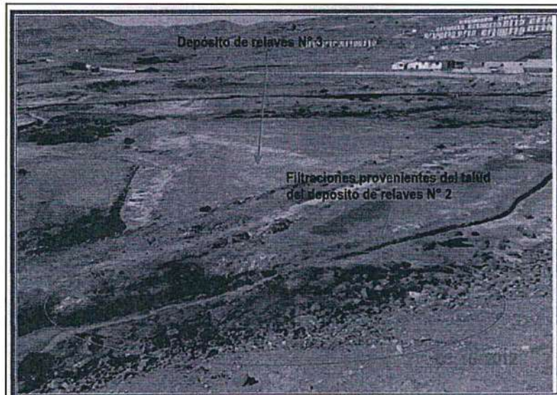
FOTOGRAFIA N° 35.- Observación N° 7: En el depósito de relaves N° 3, se ha identificado filtración proveniente de los depósitos de relaves N° 1 y 2, así como de flujos de la planta de procesos, que están originando la oxidación del material de relave.
