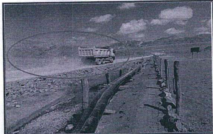
FOTOGRAFIA N° 27.- Observación N° 4: Se observó la emisión de material particulado (polvo) en la zona de Condorcayán, por deficiencias en el programa de control de polvos.
