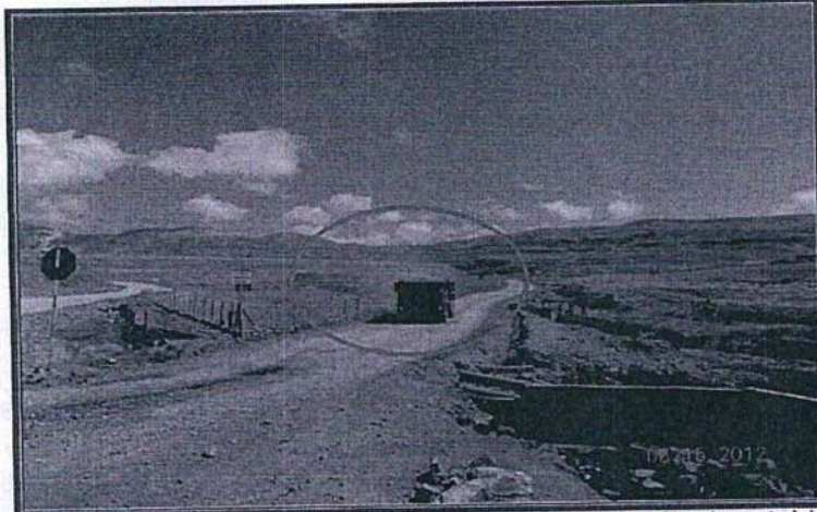
FOTOGRAFIA N° 26.- Observación N° 4: Se observó la emisión de material particulado (polvo) en la zona de Condorcayán, por deficiencias en el programa de control de polvos.
