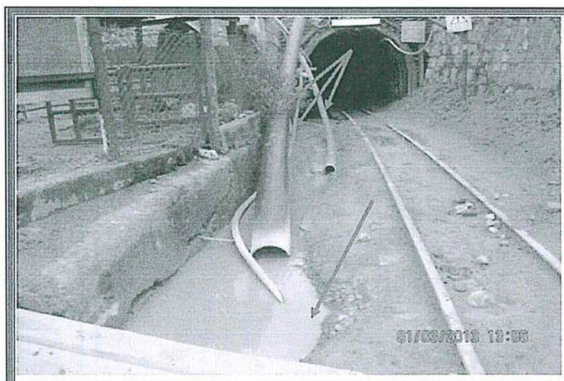
FOTOGRAFÍA N° 12.- El agua de mina que sale por la bocamina Nivel 500 Norte – El Poderoso es conducida (en parte del tramo) por un canal habilitado sobre el suelo y sin impermeabilización. Del mismo modo, el administrado ha colocado 03 tuberías HDPE de color negro de diferentes diámetros que llegan al canal que conduce las aguas de mina.
