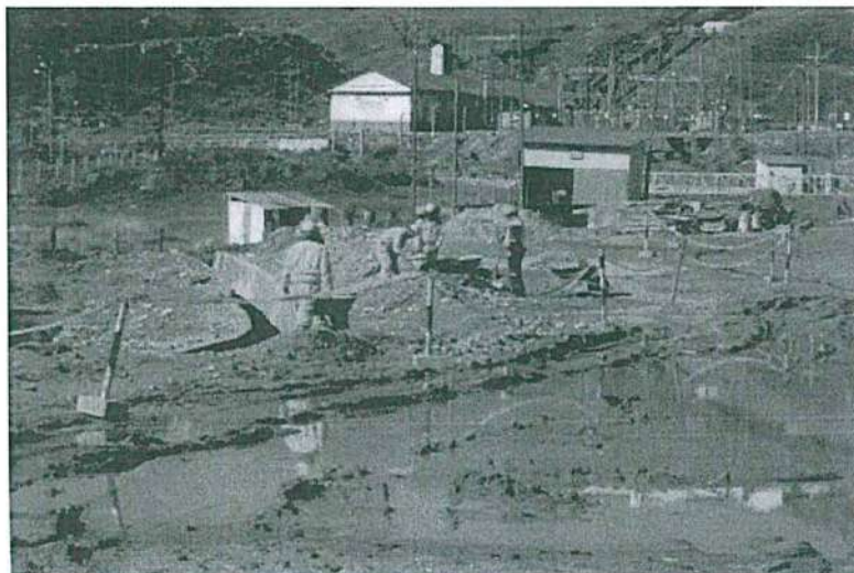
Se observa los trabajos iniciales de la construcción del canal.
