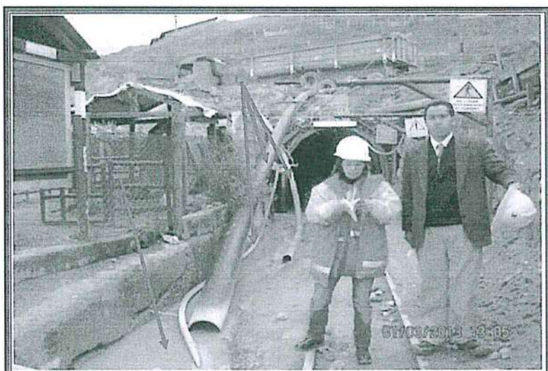
FOTOGRAFÍA N° 11.- El agua de mina que sale por la bocamina Nivel 500 Norte – El Poderoso es conducida (en parte del tramo) por un canal habilitado sobre el suelo y sin impermeabilización. Del mismo modo, el administrado ha colocado 03 tuberías HDPE de color negro de diferentes diámetros que llegan al canal que conduce las aguas de mina.
