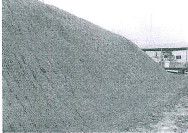
Foto N° 10: Talud con la Geomenbrana y con el control de erosión correspondiente
